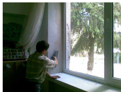
Фото – 14. Батько бере участь у ремонтних роботах після завершення встановлення вікон у дитячому садочку, Івано-Франківська область
