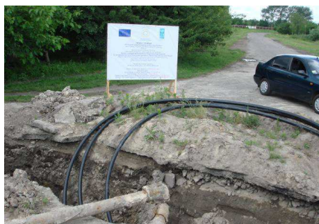
Фото - 13. Ремонт системи водопостачання, с. Єрківці Київської області
