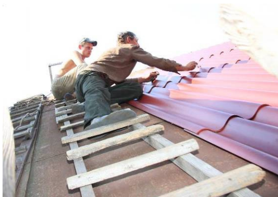
Впровадження проекту громади з енергозбереження (заміна даху)
