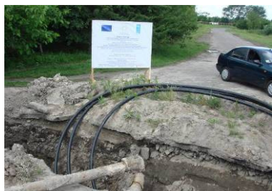
Ремонт водогону у Єрківцях Київської обл.
