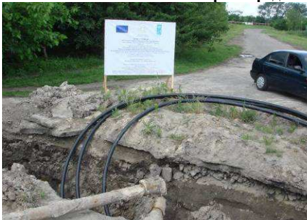
Ремонт водогону у Єрківцях Київської обл.
