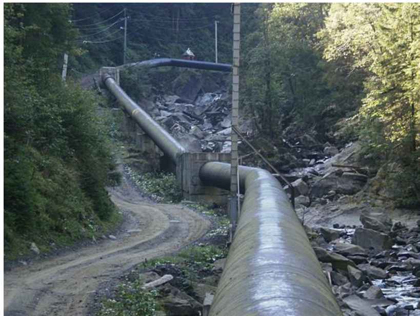
Рисунок 4.3. Трубопровід Пробійницької ГЕС № 1
