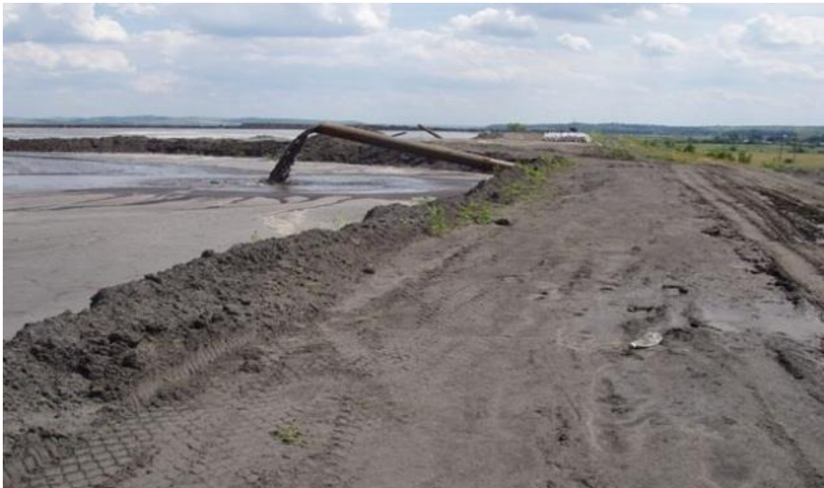
Рисунок 1.16. Бурштинська теплова електрична станція. Золівідвал № 2 [34]
