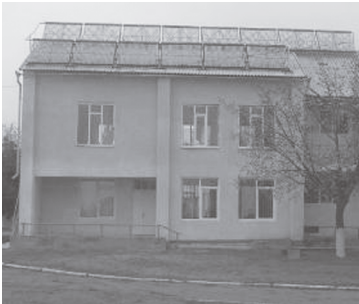
Мікропроект реалізовано МРФ-1 в с. Казарлик Одеської області; додатково до електроаккумуляційного обладнання (опалення і ГВП) були встановлені вакуумні сонячні колектори за для забезпечення ГВП.
